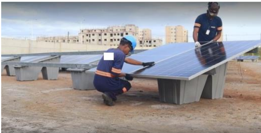
Figura 2 – Suporte com painéis fotovoltaicos sendo montados
